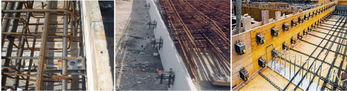
Algunas disposiciones comunes de pasadores en simple y doble hilada
