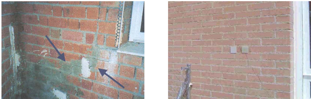
Fig 1.- Tipos de testigo: mediante yeso y elongómetro.
